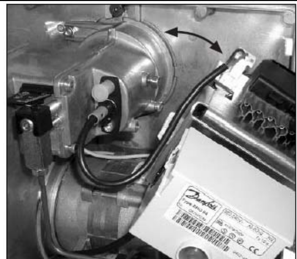
Рисунок 30 – Снятие блока управления
