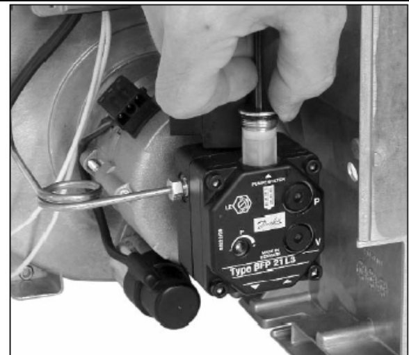
Рисунок 29 – Демонтаж топливного фильтра
